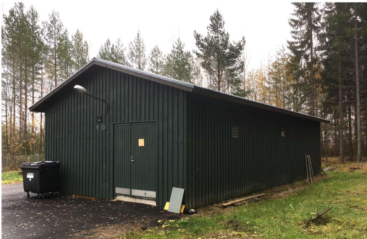
Kuva 5. Kuva jätevedenpuhdistamosta (syksy 2019).
